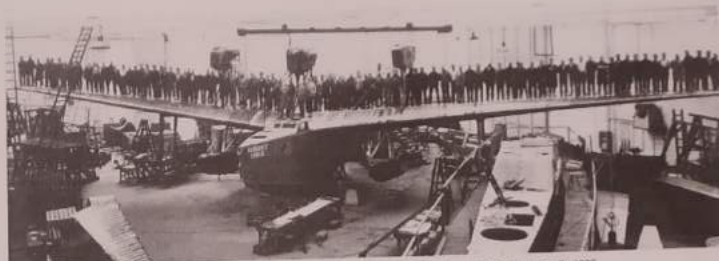
100 Arbeiter bei der Belastungsprobe der Tragflächen des Flugbootes „Romar“ in der Flugzeughalle in der Kiautschoustraße 1927
