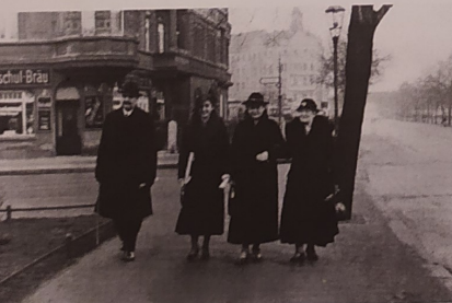
Ecke Samoastraße / Nordufer, Blickrichtung nach Osten, im Hintergrund das Eckhaus Lynarstraße / Nordufer (im Krieg zerstört) und die Brücke der Ringbahn, 1937
